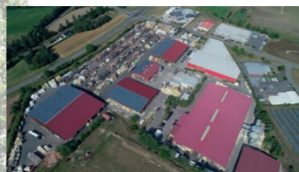
Holzzentrum Ziegler | Pressath
