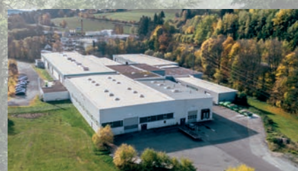
Construction de modules | Naila
